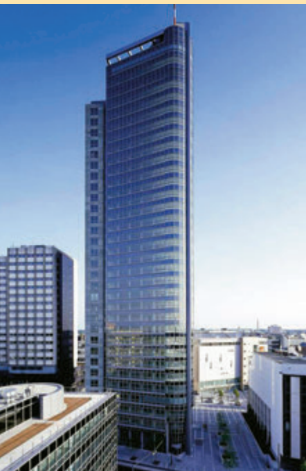
Salih Taşdirek’in firması Erbacher-Kolb’un yaptığı kilit sistemi projelerinden biri City Tower Offenbach’da uygulandı.
